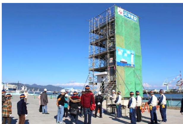
<灯台製作現場見学の様子>
